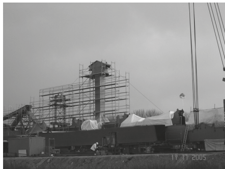
Obr. 4: Pracovní a zabezpečovací konstrukce
