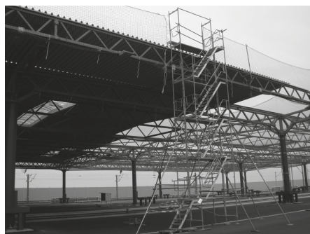
Obr. 13: Volně stojící schodišťová věž
