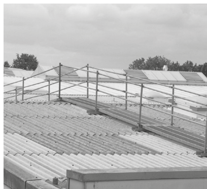
Obr. 15: Povrch, umožňující rozložení zatížení
